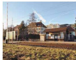
L'ancienne gare de La Chaux-de-Fonds-Ouest sera réaffectée si le Transrun est construit. Elle serait rebaptisée Fiaz. ARCHIVES CHRISTIAN GALLEY
