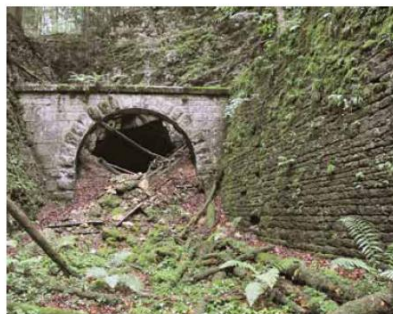
Le portail nord de l'ancien tunnel du Creux, désaffecté en 1888, après 14 ans d'utilisation seulement. RICHARD LEUENBERGER.
